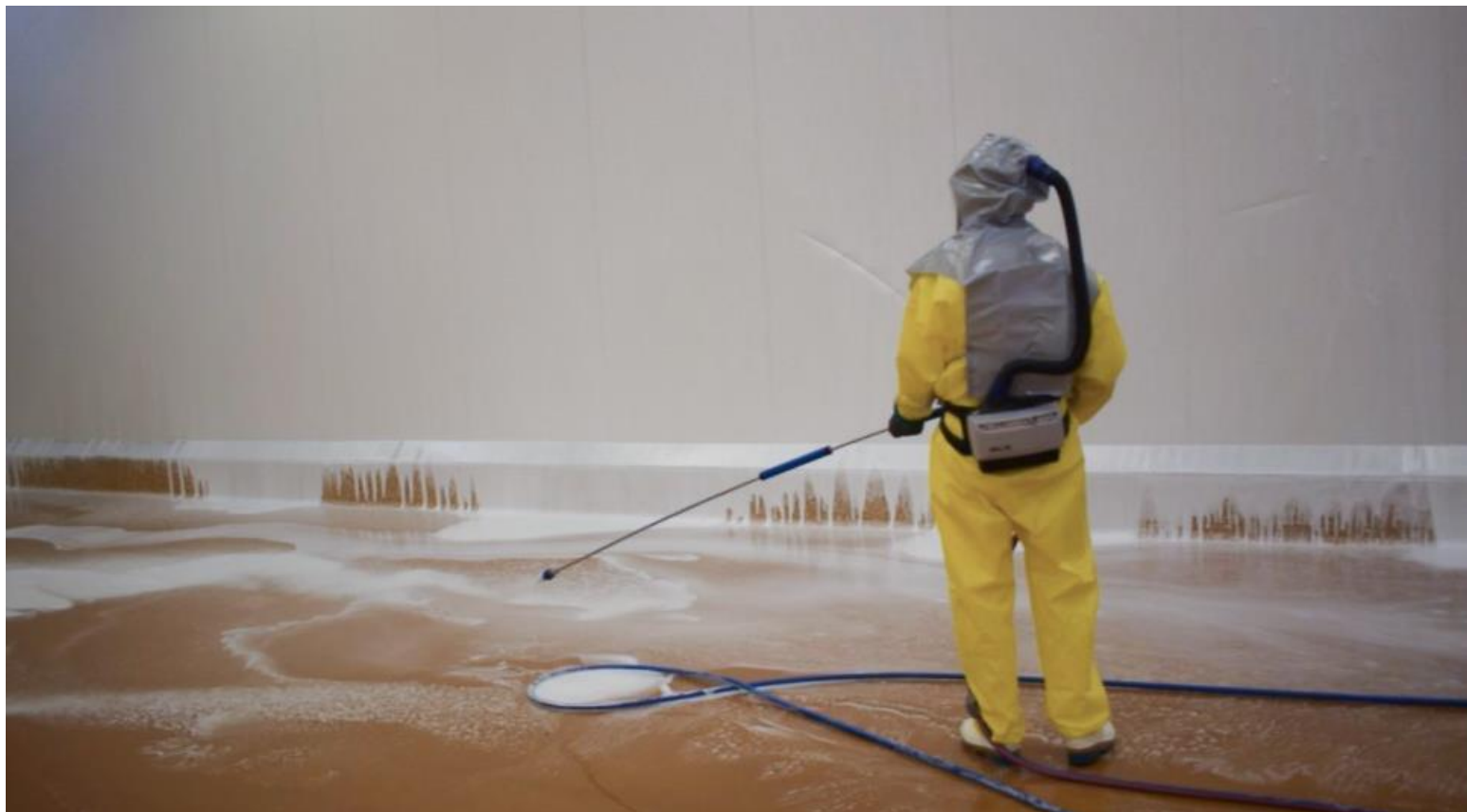
Skumudlægning af væg i produktionslokale
